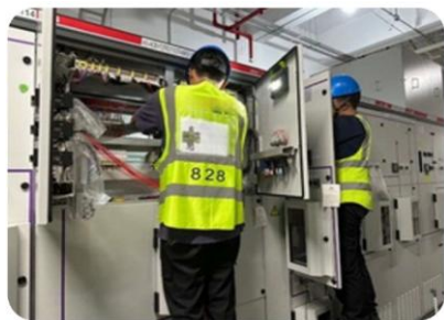
電力工程施作
