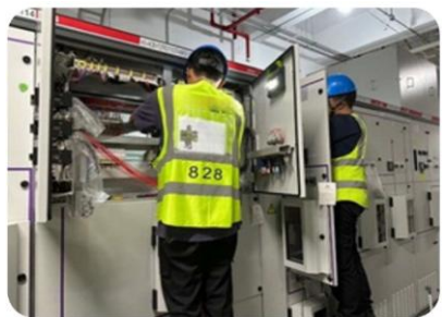
電力工程施作
